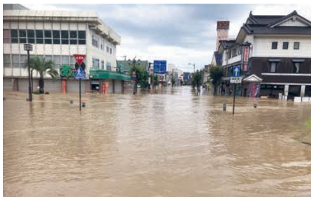
令和2年7月豪雨の状況(人吉駅前)
