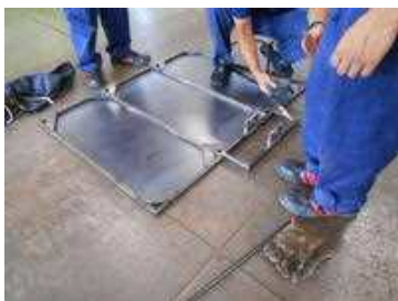
リヤカー製作（溶接）
