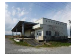
冷蔵冷凍施設
