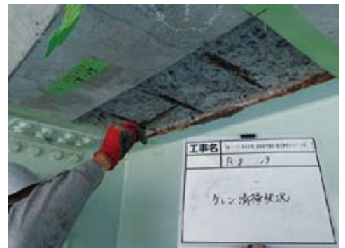
<橋りょう補修状況>床版補修
