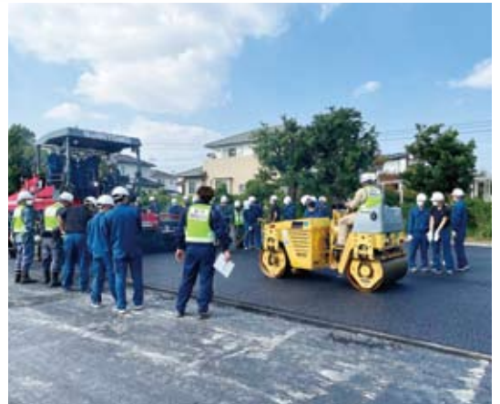
高校生向け舗装実習「建設業ナイスライ」
