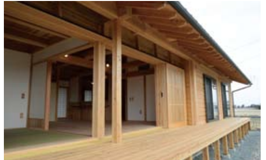
伝統構法を用いた木造建築物
