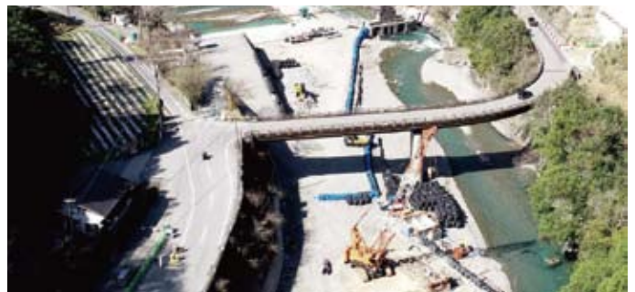
<整備状況> 国道445号（五木村）
