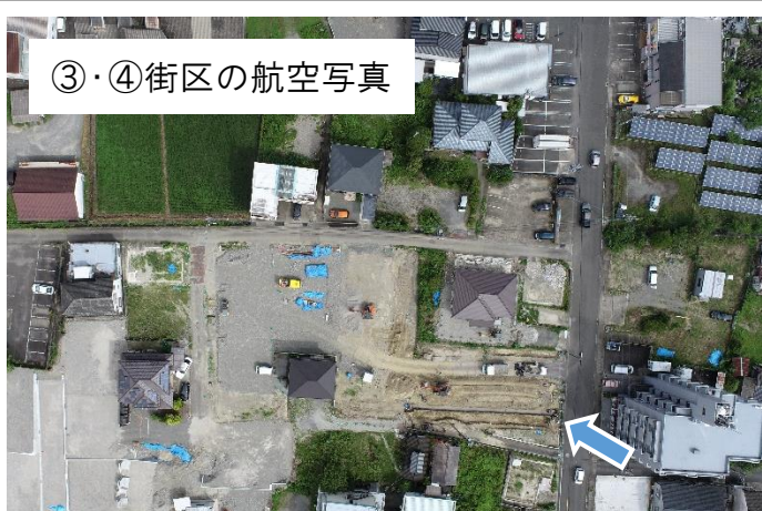
工事施工中(R7.9 時点)
