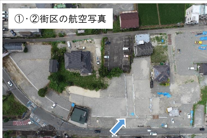
工事施工中(R7.9 時点)
