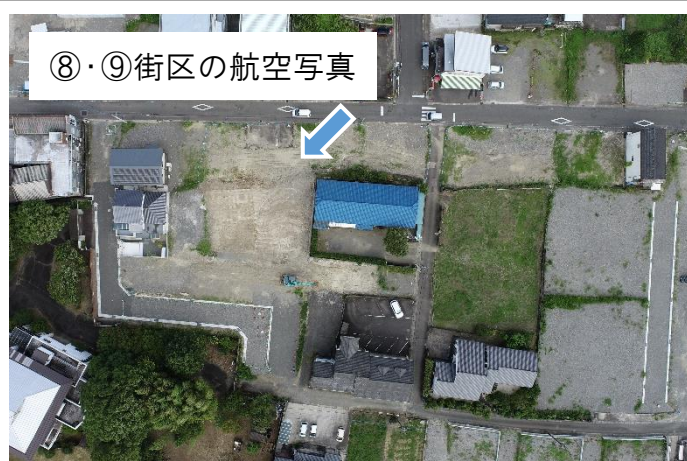
工事施工中(R7.9 時点)
