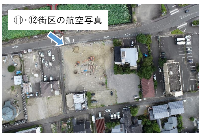
工事施工中(R7.9 時点)
