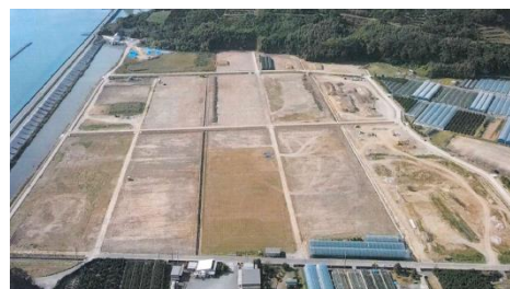
<区画整理施工状況（R4.10）>
