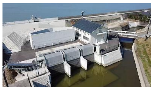
<豊川中央排水機場（R3.7月供用開始）>
