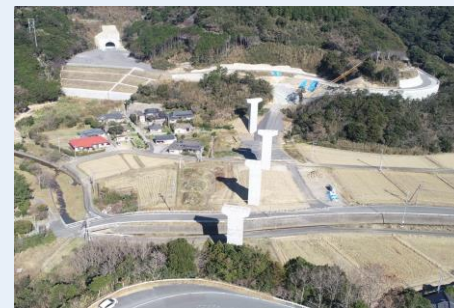
国道389号下田南BP(天草市)
