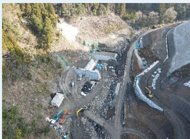
【砂防】川内川砂防堰堤整備(球磨村)
