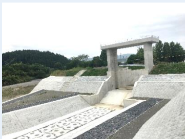
【河川】御溝川二次放水路整備(人吉市)
