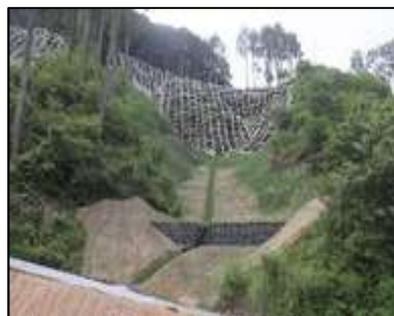
流木捕捉式ダムの整備による流木等の抑止対策
