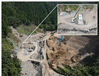
【砂防】川内川(球磨村)砂防堰堤整備
