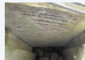
【橋りょう】第3畑橋(菊池市)の補修
