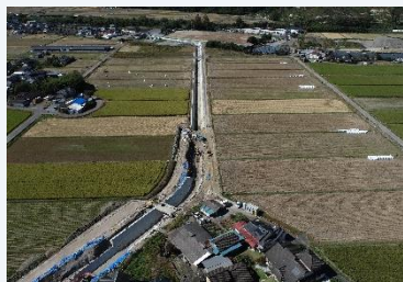
【河川】御溝川(人吉市)二次放水路整備
