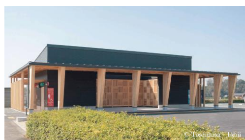
【賛助施設】 道の駅「泗水」防災トイレ(菊池市)
