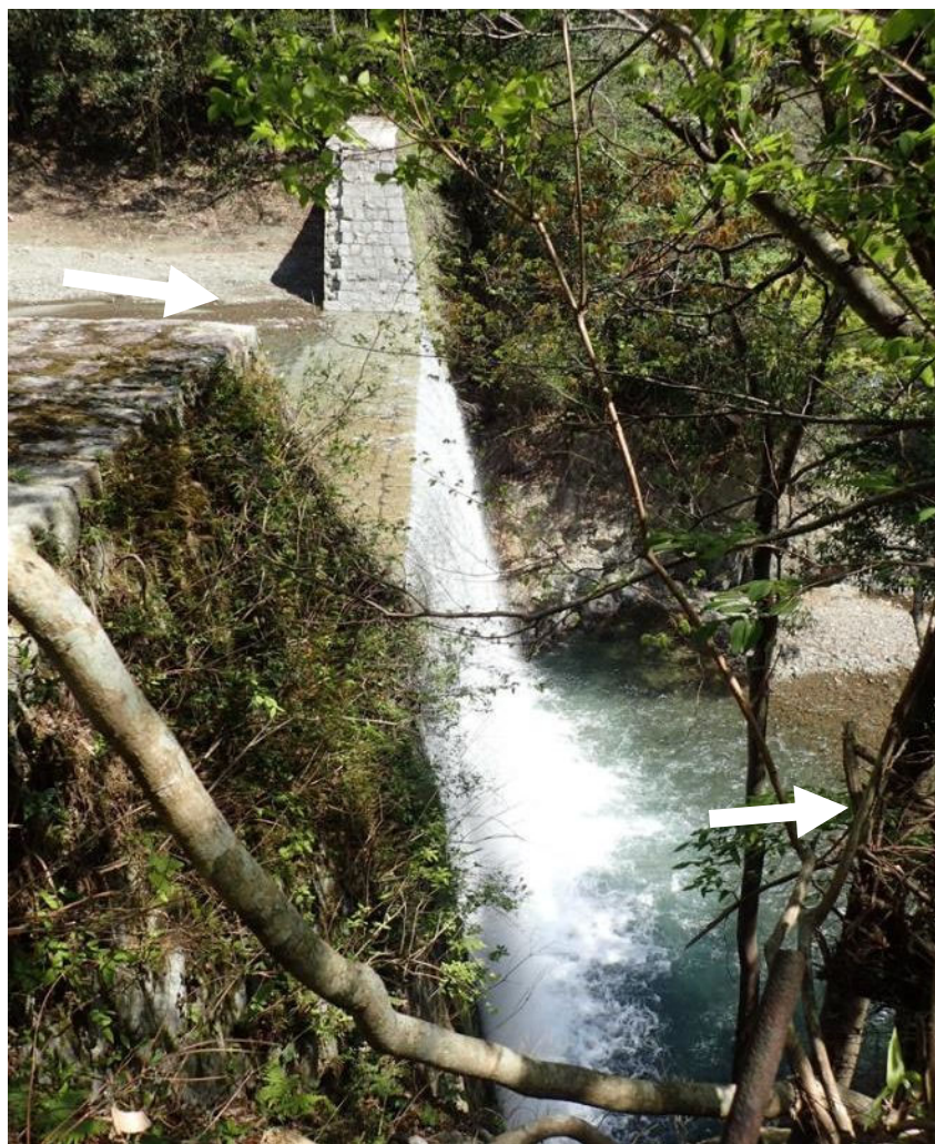
図 1-6 宇那川合流点直下の万江川砂防堰堤 2（令和 3 年 4 月撮影）
