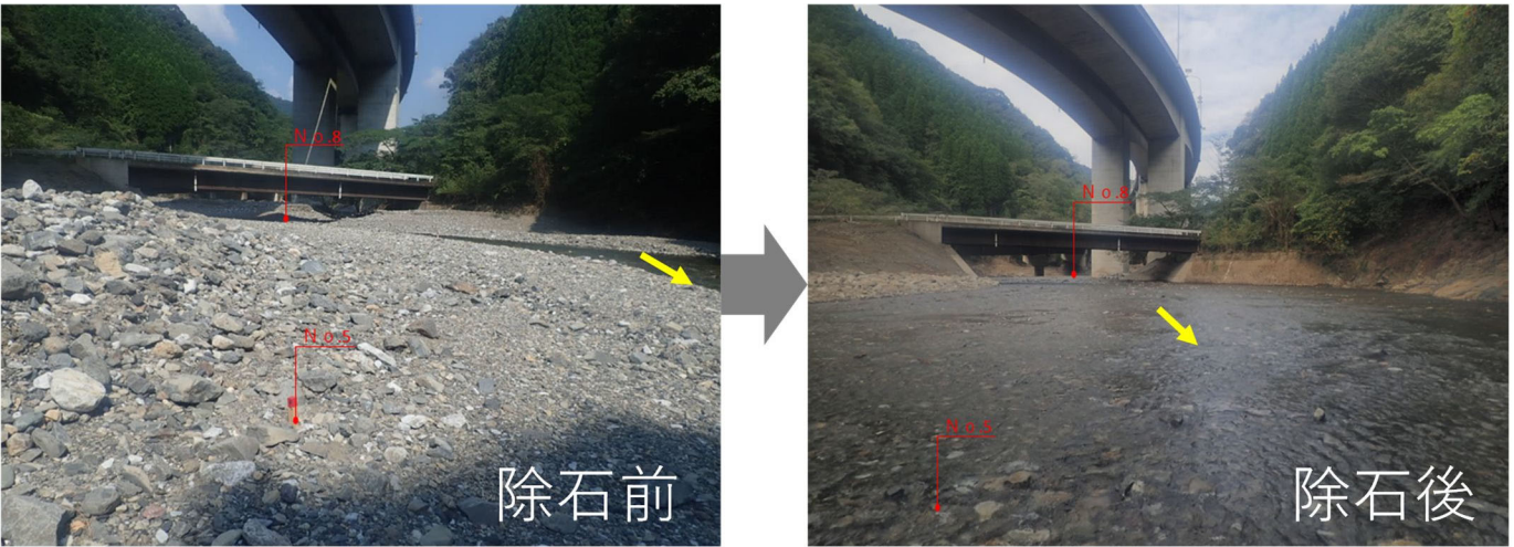
図 2-5 万江川・宇那川合流点上流の除石工事前後の状況（左：着工前、右 2021 年 11 月）
