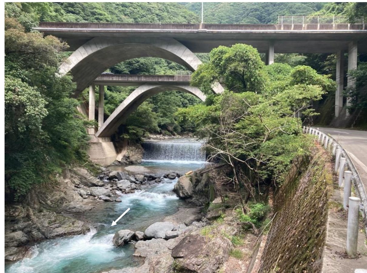
図 1-7 高速道路横過部と、その直上流に見える万江川砂防堰堤 1（令和 4 年 8 月撮影）
