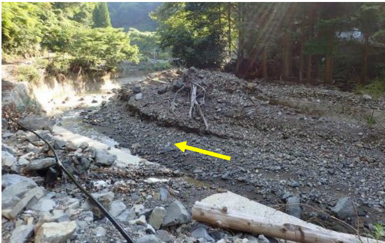
図 2-3 万江川河道内の土砂堆積状況（2021 年 7 月 6 日）
