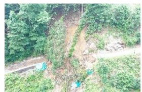
⑧林道の法面崩壊(球磨村)
