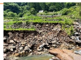
⑦農地の法面崩壊(球磨村)
