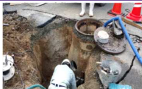
応急復旧 (バイパス管)
