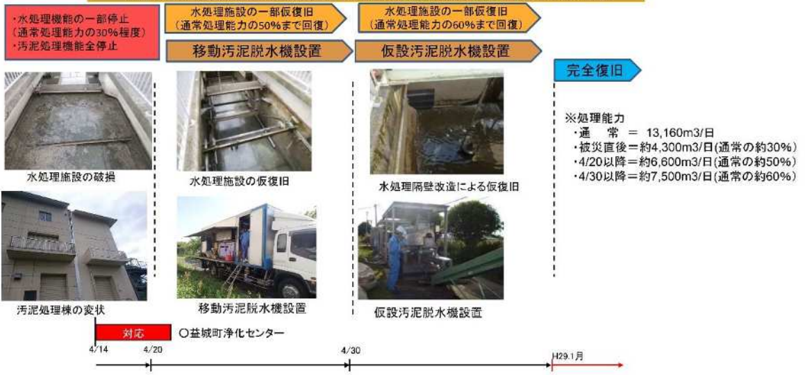
図 下水処理場の段階的普及の実績
