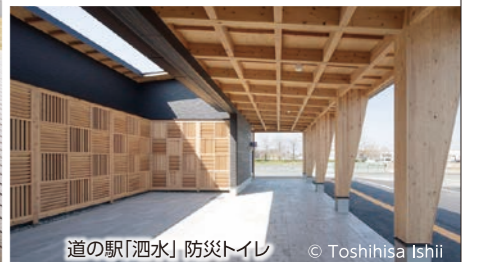
道の駅「洒水」防災トイレ
