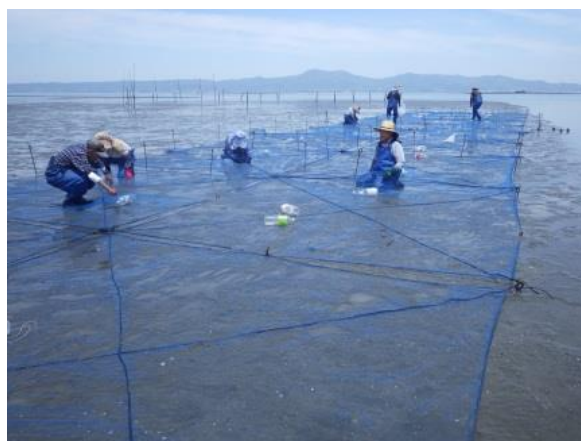
図5 2 被覆網の設置状況 (平成 28 年 八代海郡築地先)
