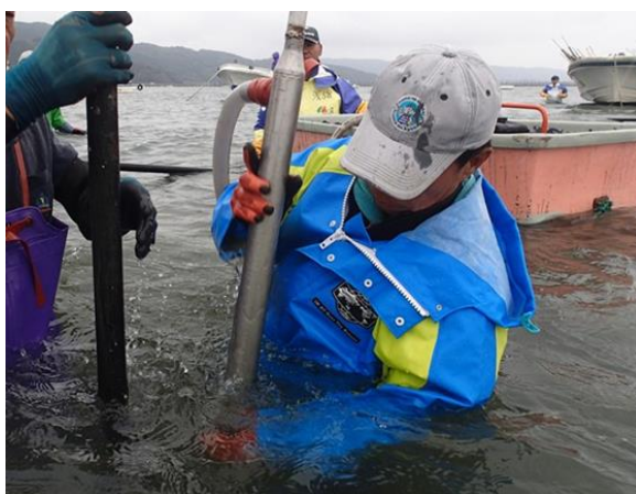
図38 FRPパイプの建立作業 (平成27年 有明海：住吉地先)
