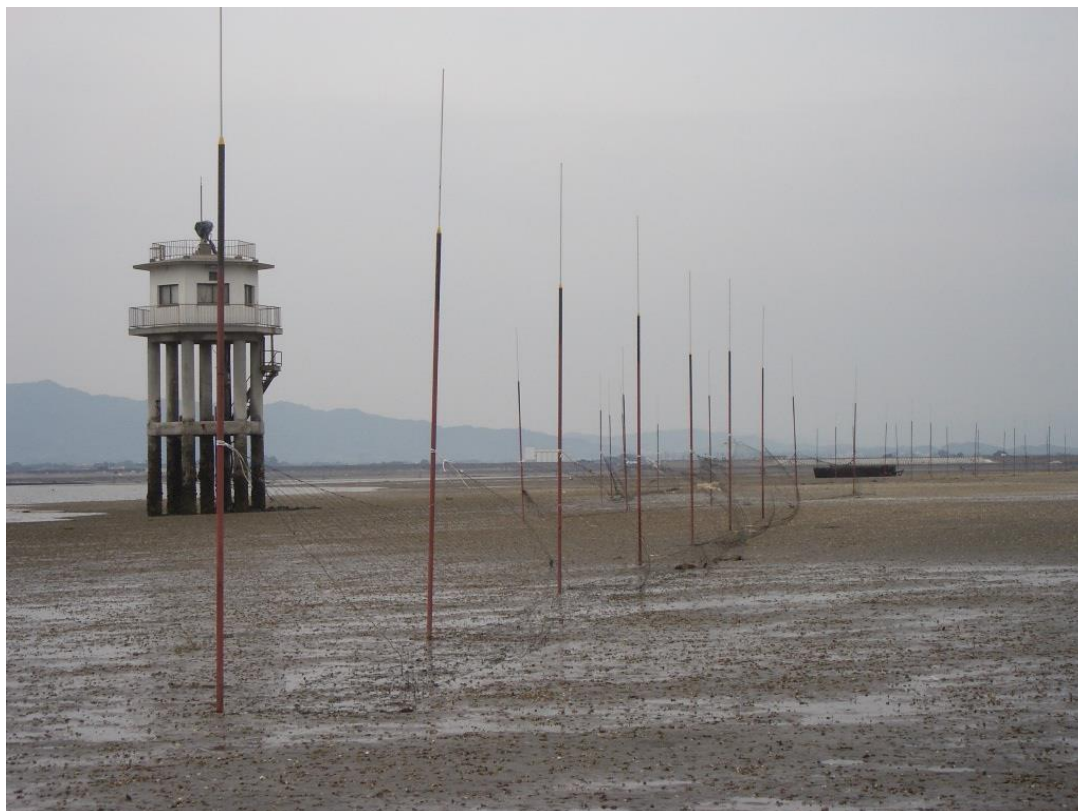
図50 囲い網の設置状況（平成15年頃 有明海滑石地先）
