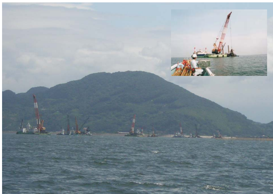
写真26 白川河口域での工事实施状況(平成17年度)
