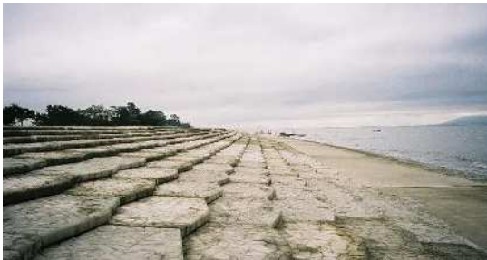
緩傾斜護岸（荒尾海岸）
