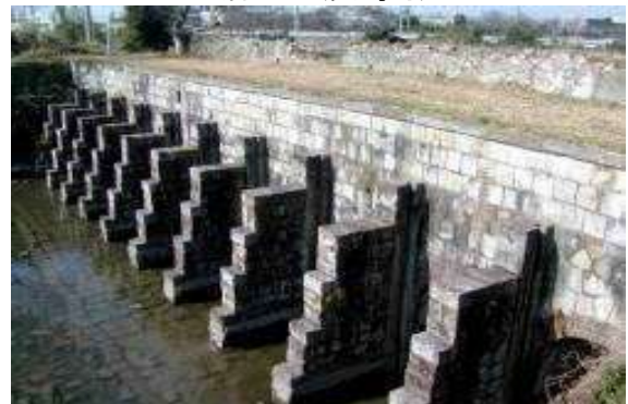
旧郡築新地甲号樋門(八代市)
