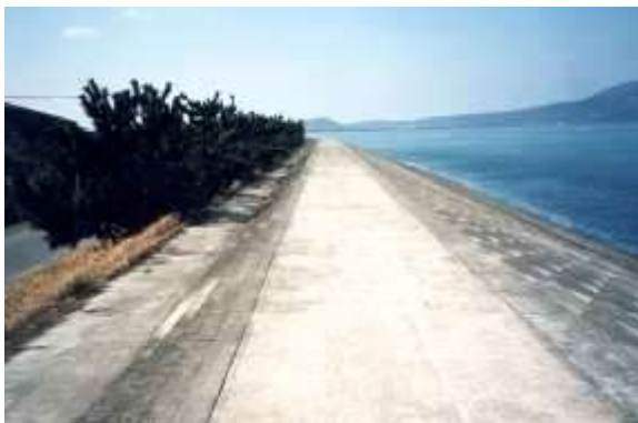
緩傾斜護岸と松林(出水海岸)
