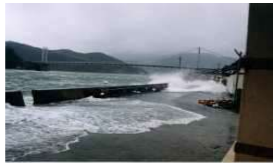
越波による被害(上天草市龍ヶ岳町)
