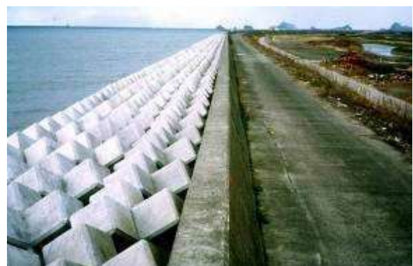
堤防(消波工)(金剛海岸)
