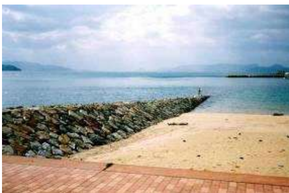
突堤、養浜(中形浦海岸)
