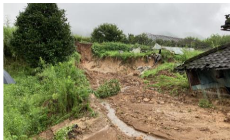
① 農地の法面崩壊（山鹿市）
