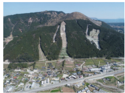
【治山事業による復旧状況】
