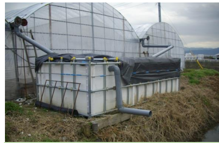
雨水利用を利用した施設園芸の灌水システム
