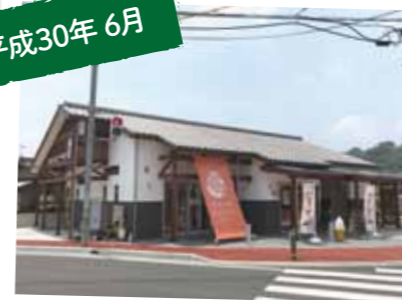
木葉駅トイレの解体・新築がなされ、同時に新たな観光拠点であり特産品販売・通信販売事務所として「ぶらっとぎょくとう」の整備が行われました。
