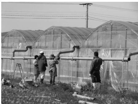
写真6 送水管の設置状況
