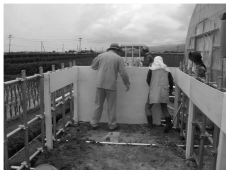
写真3 合板の設置状況
