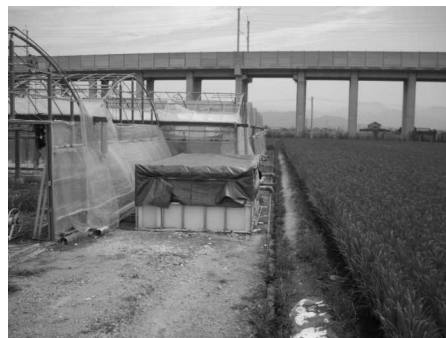
写真5 防草シートの設置状況
