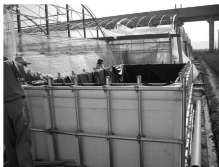
写真4 軟質塩化ビニルシートの設置状況
