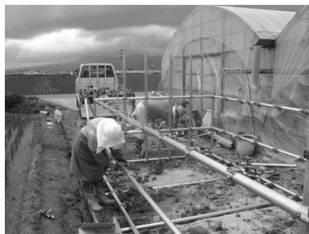
写真2 足場用単管パイプの設置状況
