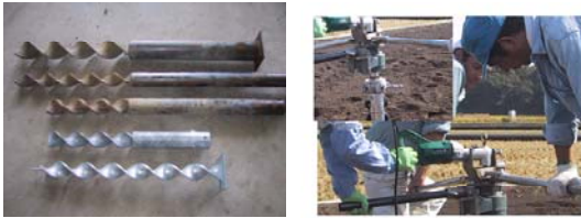
写真2 各種スパイラル杭と施工状況
