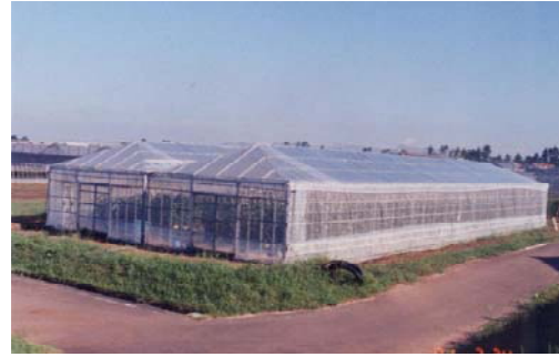
写真1 熊本型試作ハウス (間口 6m、軒高 2.5m 棟高 3.8m、3m スパン)
