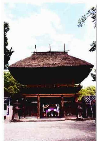
⑤楼門 神社への入口に建つもので、この楼門は、2階建てで1重目に廻縁が造られています。また、垂木には「人吉様式」と言われる神面が四方に取り付けられています。
