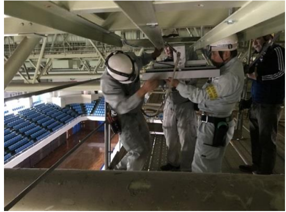
改修工事状況
