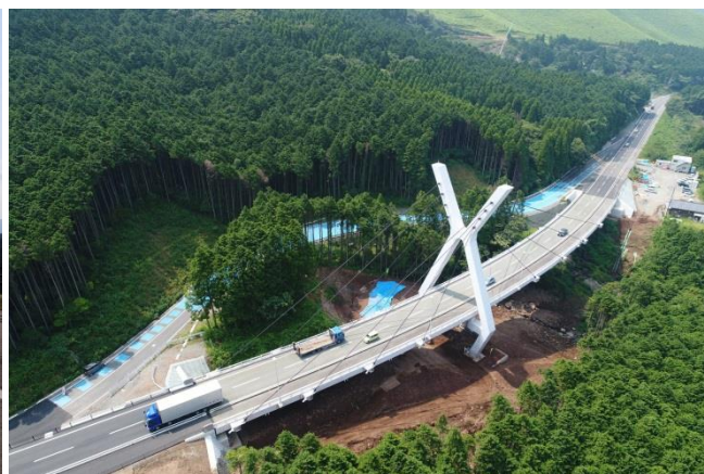
俵山トンネルルート(桑鶴大橋)が 復旧(7月)【提供:国土交通省】
