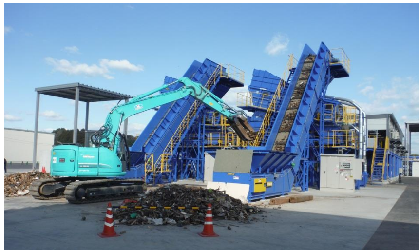
岡山県での再活用が決定した 廃棄物処理プラント
