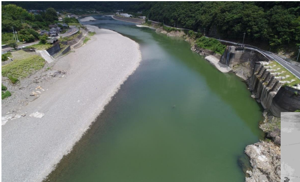
荒瀬ダム撤去後の様子(上流から下流を望む) 【右の写真は、昭和29年建設当時】⇒
