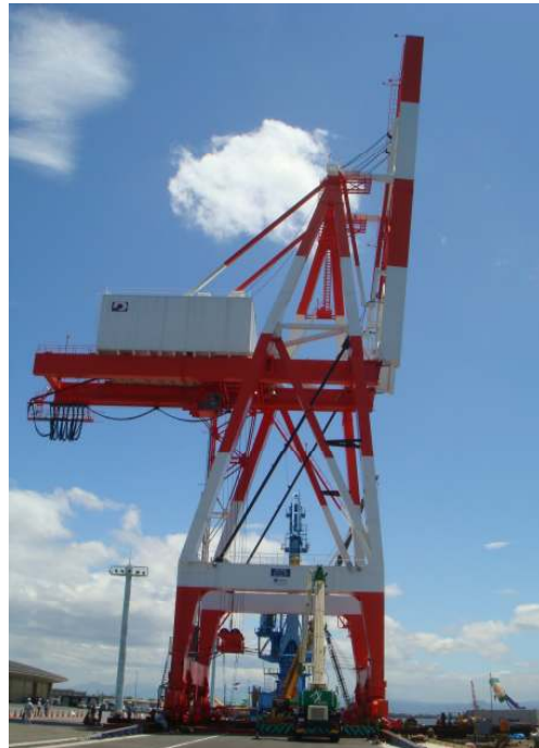
完成に向け整備が進む ガントリークレーン【熊本港】
