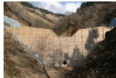
県産木材を使用した残置式型枠により築造した治山施設（阿蘇市一の宮町）
