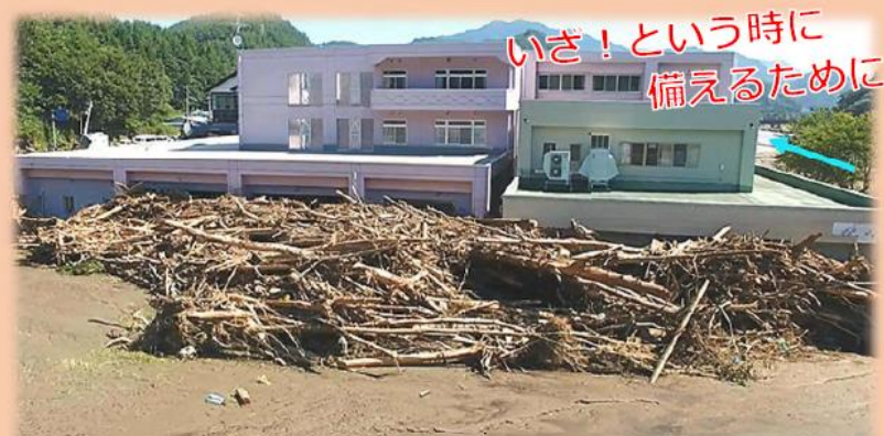
写真：平成28年台風第10号要配慮者利用施設被災状況 岩手県岩泉町（撮影 国土地理院）
