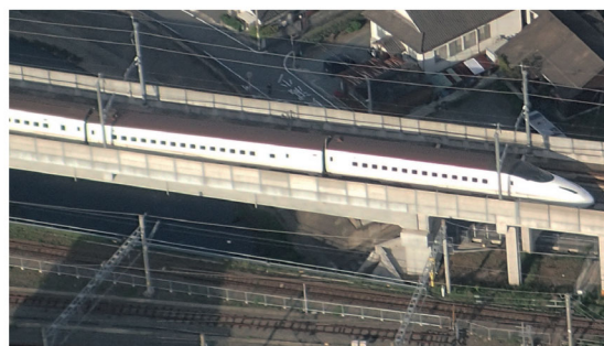
脱線した九州新幹線 4月16日撮影
