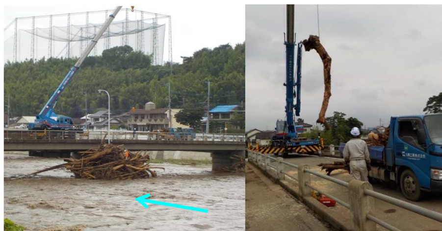
平成28年6月21日 クレーンによる撤去作業
