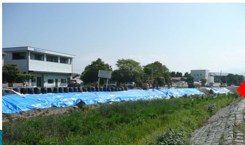
シート張り工及び大型土のう積み工完了 (他の箇所では応急対策継続中、平成28年5月1日撮影)
