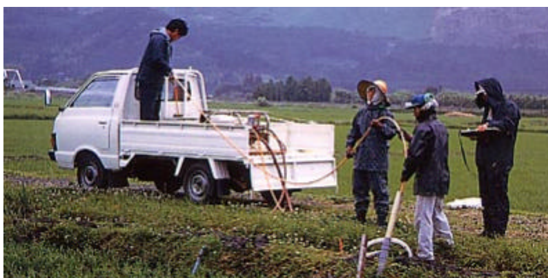
図 2 暗渠目詰まり作業状況（暗渠上流）
