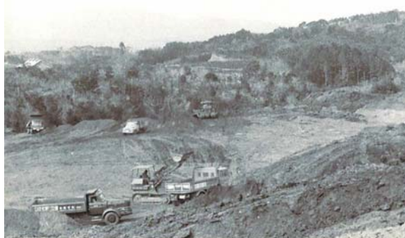
果樹試験場造成工事
