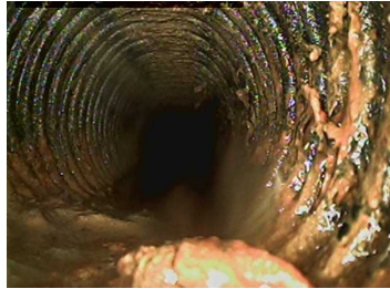
暗渠管の凸凹が見える程度の付着
