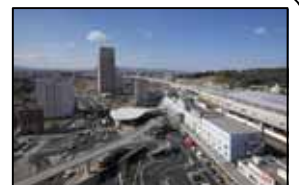
熊本駅白川口(東口) 駅前広場
