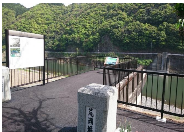
撤去後の左岸展望スペース
