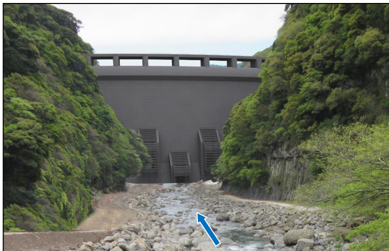
上流側からダムを望む
