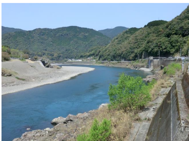
撤去完了後(H30. 3月)
