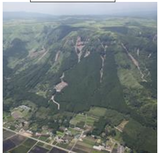
土砂崩壊状況 (北外輪山)
