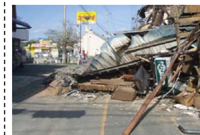
地震直後の県道熊本高森線の状況
