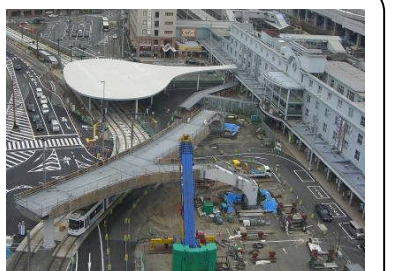
熊本駅周辺の整備状況
