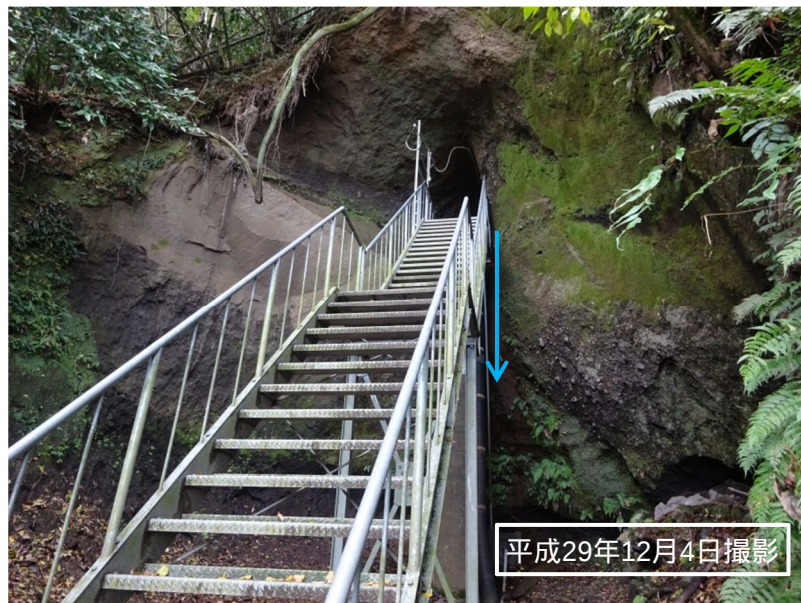
(写真1) 発電機上流側の状況
