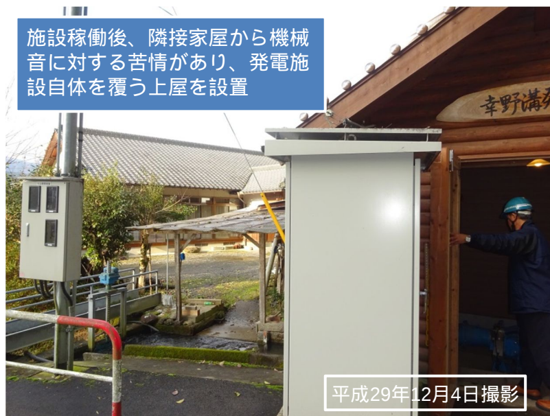
(写真2) 隣接民家の近接状況
