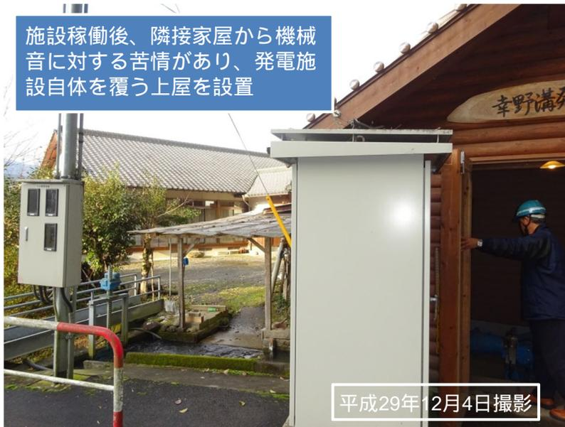
施設稼働後、隣接家屋から機械音に対する苦情があり、発電施設自体を覆う上屋を設置
