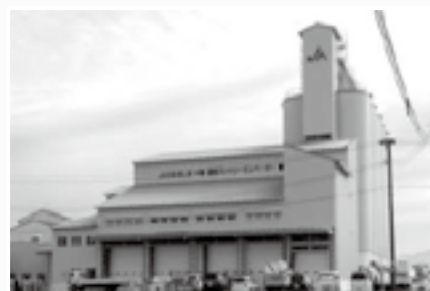
カントリーエレベーター建設(嘉島町)
