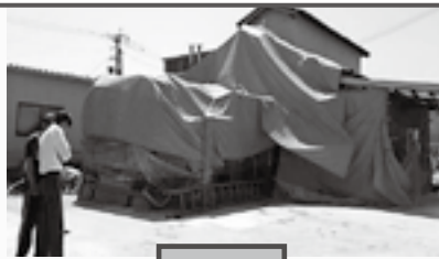
ノリ乾燥設備復旧(熊本市)
