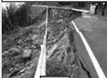
農道の復旧 (宇城市)
