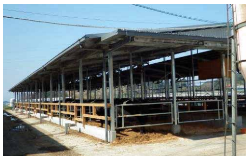
復旧した 畜舎
