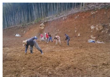
除礫作業（自力施工）状況
