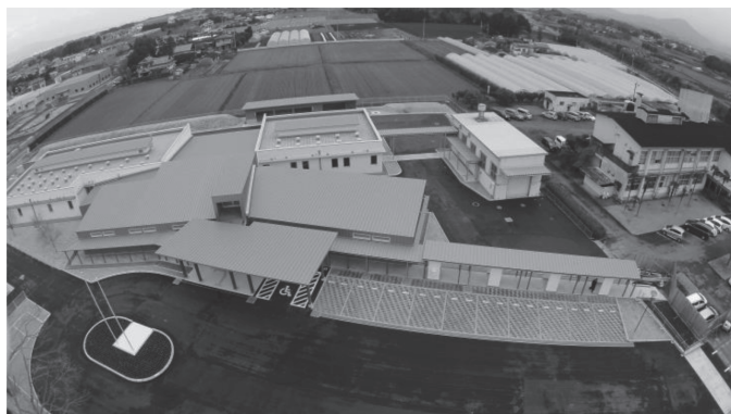
中央家畜保健衛生所の改築 (H27. 6)
