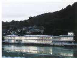
■荒瀬ダムボートハウス〔八代郡坂本村〕
