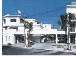
■水俣市営洗切団地〔水俣市〕
