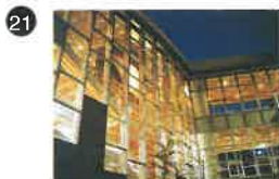
21 ■ 水俣市保健センター・ 水俣市総合もやい直しセンター [水俣市]
