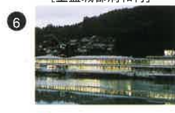
6 ■ 荒瀬ダムポートハウス [八代郡坂本村]
