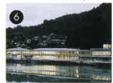
6 ■ 荒瀬ダムボートハウス [八代郡坂本村]
