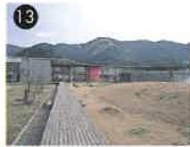
13 ■ 養護老人ホーム 八代市立保寿寮 [八代市]
