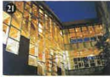
■ 水俣市保健センター 水俣市総合もやい直しセンター [水俣市]
