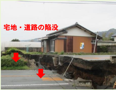
陥没による宅地・道路の段差
