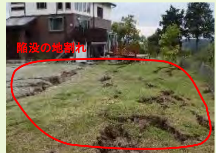
陥没による宅地の地割れ
