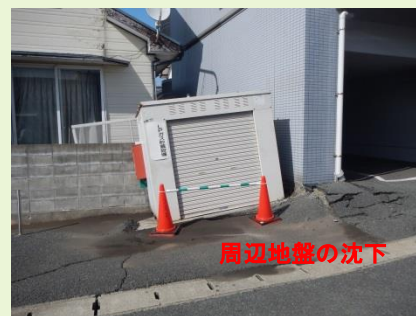
宅地地盤の沈下
